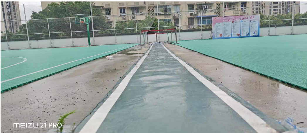
项目现状图（检查时已拆除一小段）
